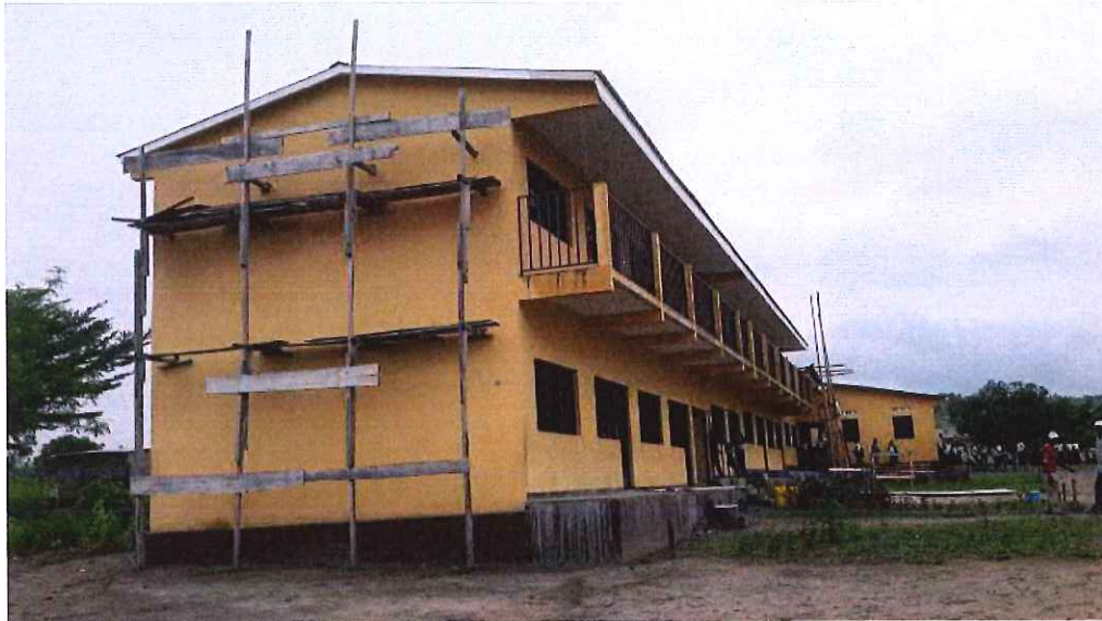
Foto 5. Nuevas infraestructuras desde otra perspectiva
