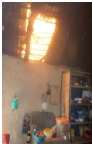
Mejora de la iluminación y temperatura de las casas a través de calaminas transparentes
