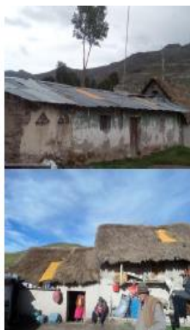
Mejora de la iluminación y temperatura de las casas a través de calaminas transparentes
