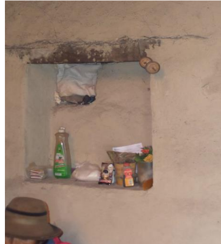
Revoque de muros y organización
